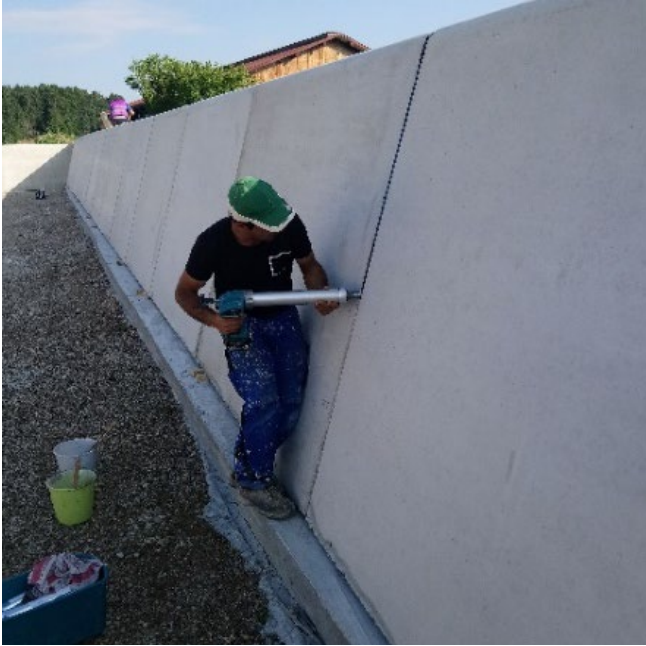
Bild 1: Neubau und Abdichtung eines Fahrsilos in Waging / Download-Link
