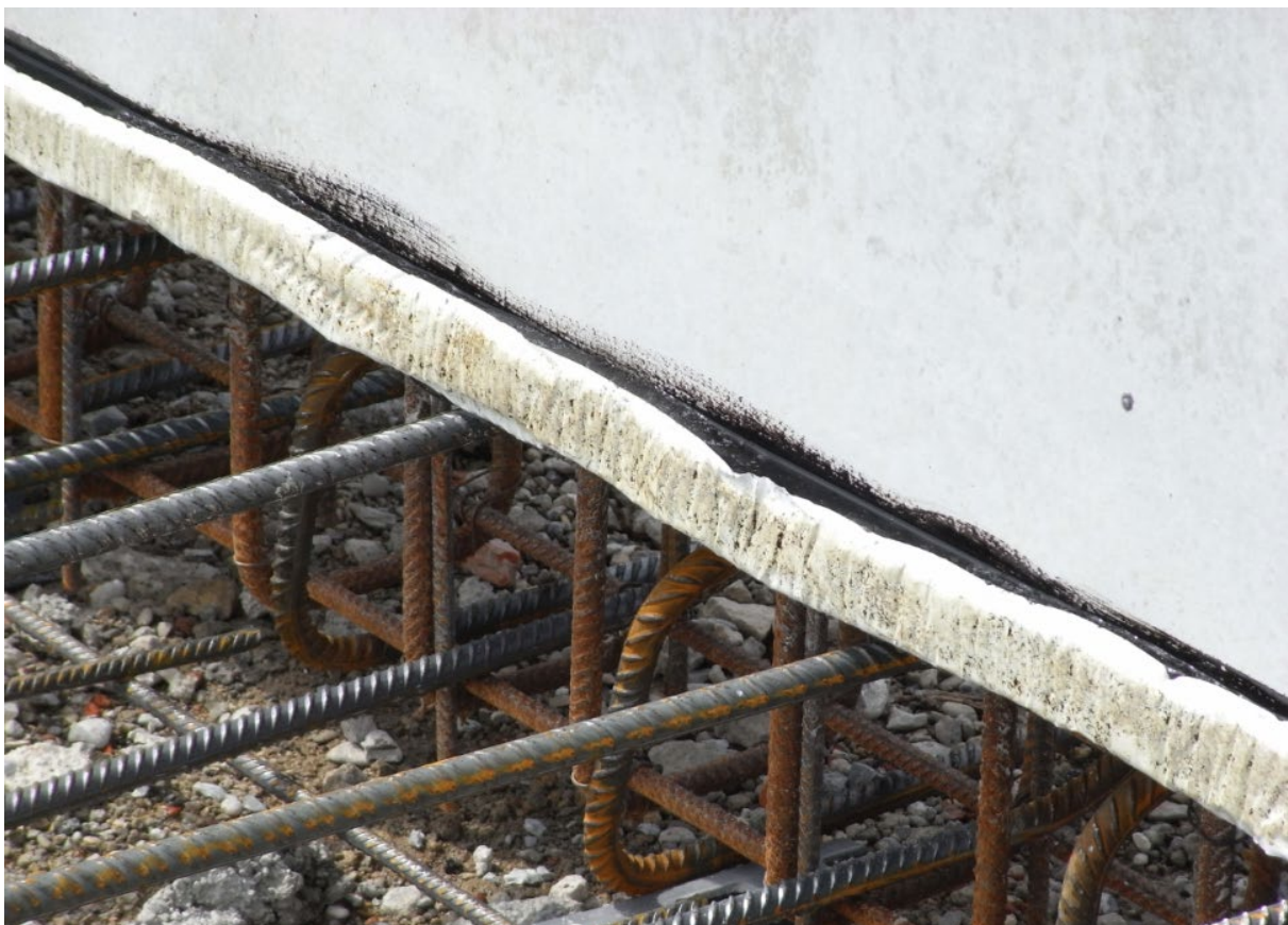
Bild 1: Neubau und Abdichtung eines Fahrsilos mit Anschlussbewehrung / Download-Link
