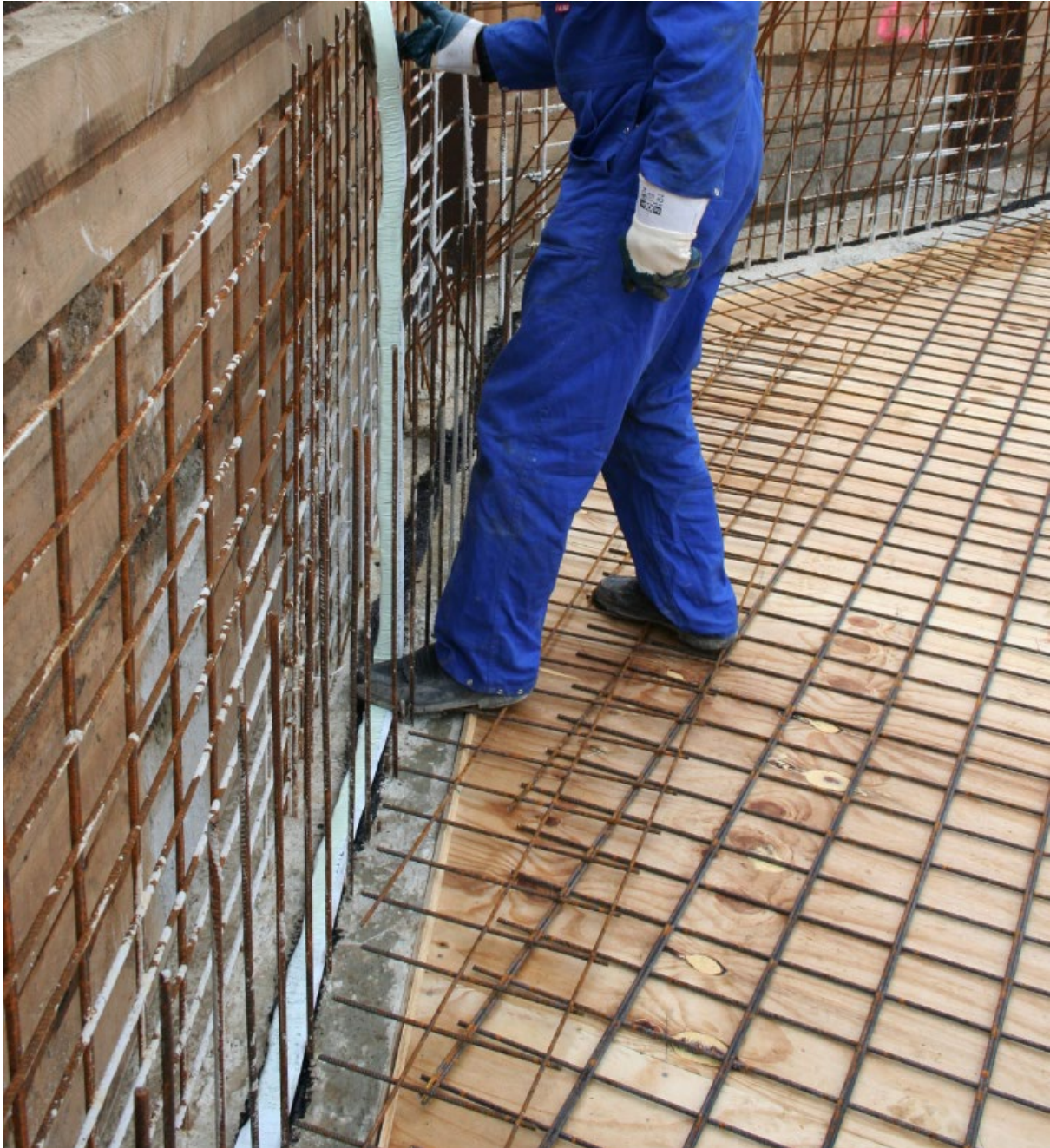
Bild 2: Neubau und Abdichtung eines Güllekellers / Download-Link
